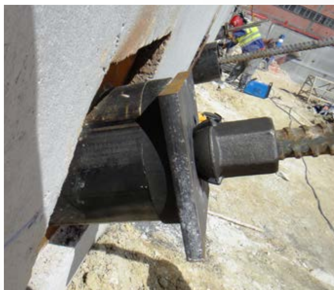
Tête de blocage métallique pour la précontrainte
