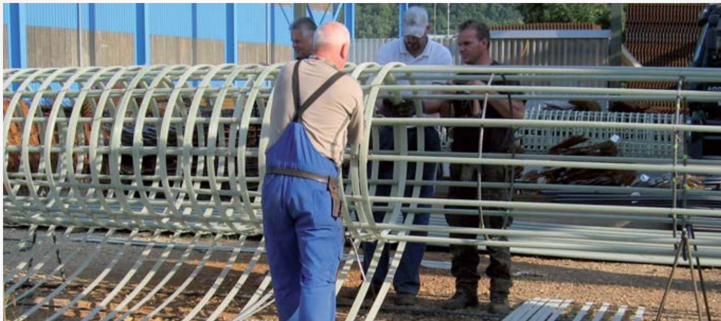
Montage d'un pieu DURGLASS® sur chantier
