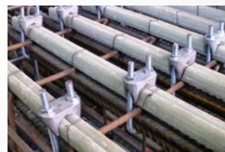
Détail du fixage par serre-câbles à U
