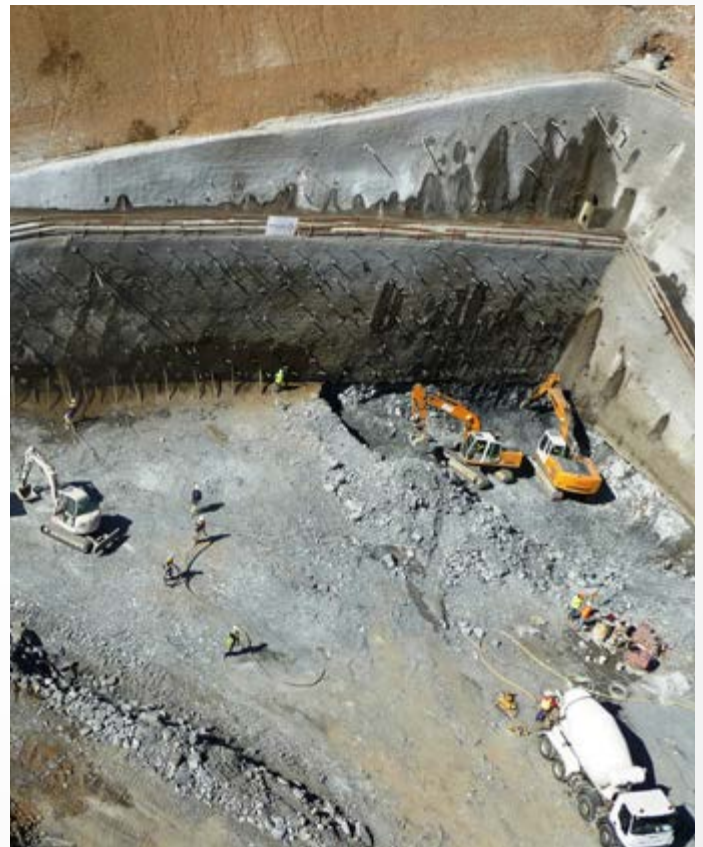
Clous DURGLASS® dans le tympan de tunnels
