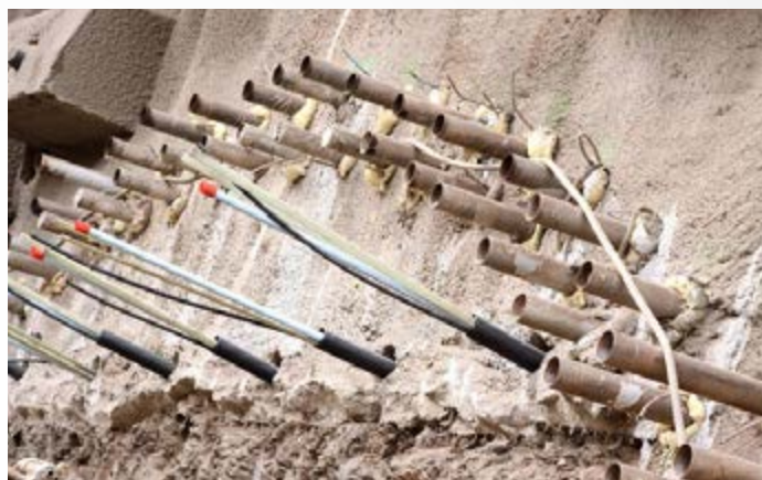
Clous DURGLASS® à l'entrée d'un tunnel
