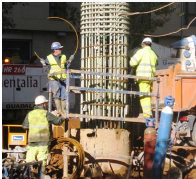
Installation d'un pieu
