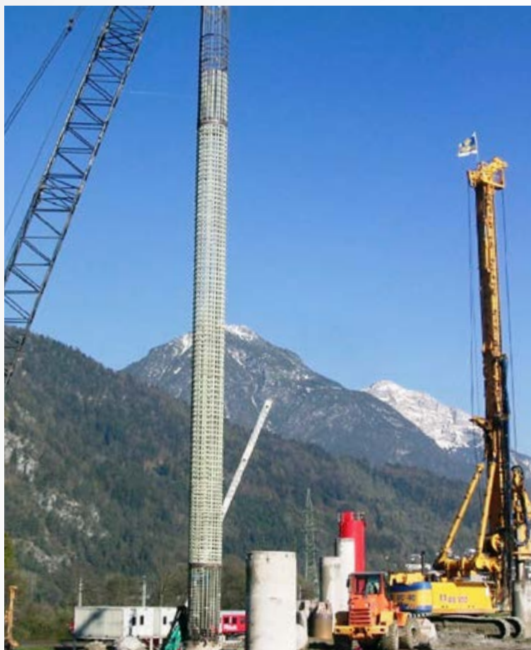
Installation d'un pieu DURGLASS®
