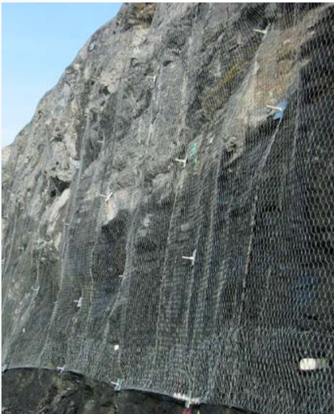
Paroi clouée avec clous DURGLASS®
