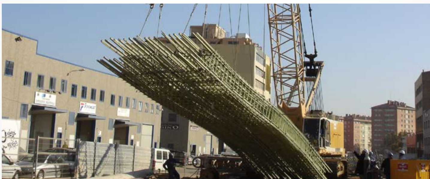
Levage d'une cage d'armature DURGLASS®
