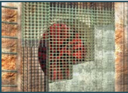
A - Cages d'armature temporaires pour le soft eye (Pg. 4)
