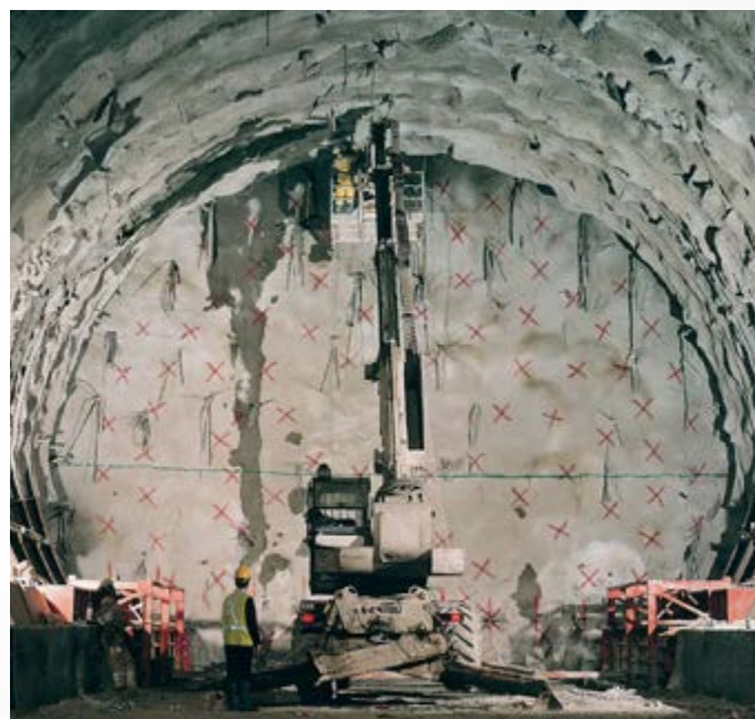
Pré-confinement du front de taille avec éléments structurels DURGLASS®
