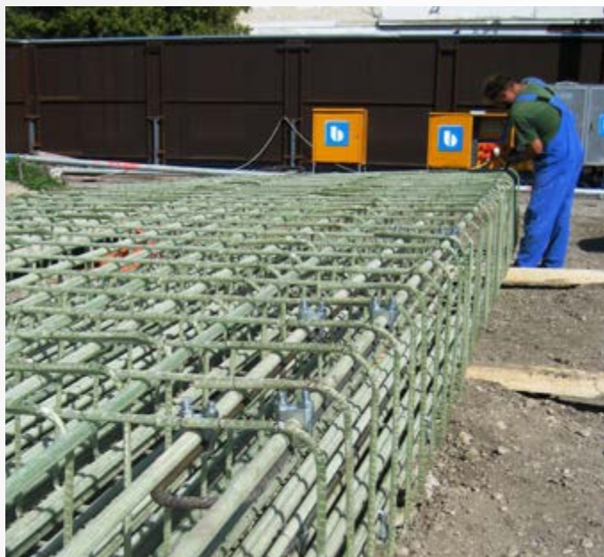
Assemblage d'une cage d'armature
