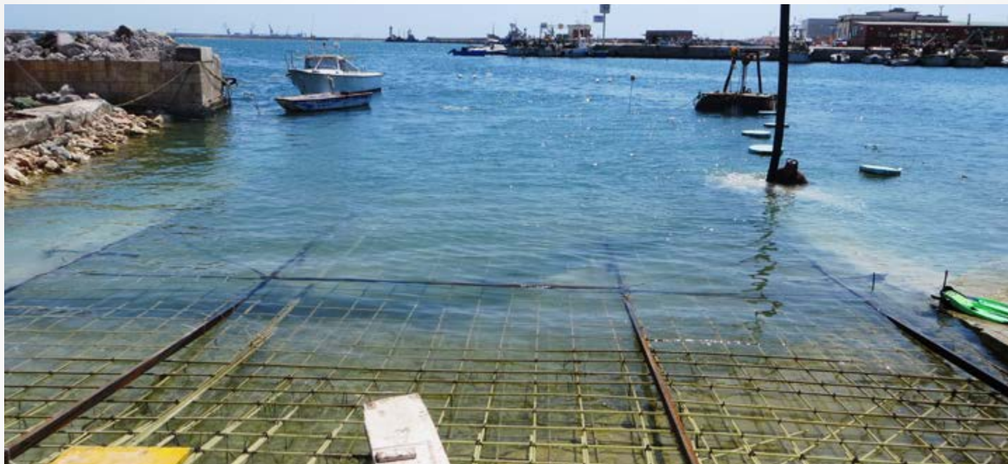
Armature GLASSPREE® pour une dalle portuaire
