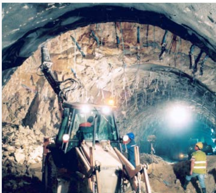
Consolidation radiale de tunnel avec barres DURGLASS® combinées avec tubes d'injection DURVINIL®
