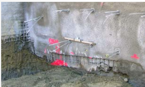
Treillis DURGLASS® scellé dans un mur de soutènement en béton projeté
