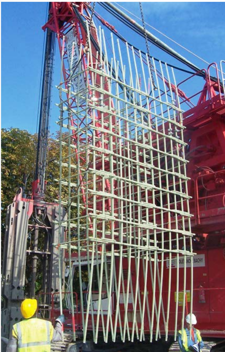
Cage d'armature DURGLASS® pour parois moulées
