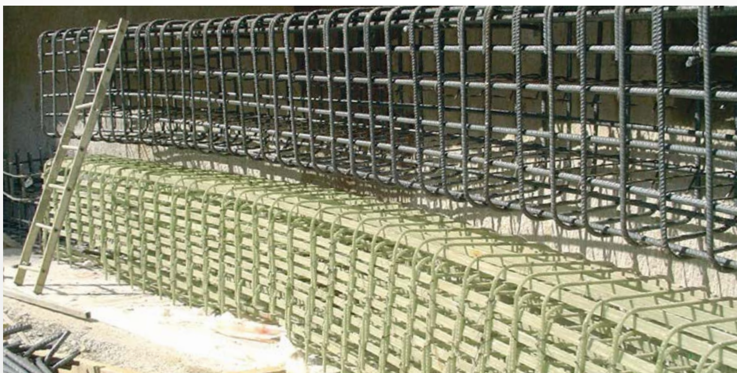
Armature DURGLASS® semi-circulaire dans un puits
