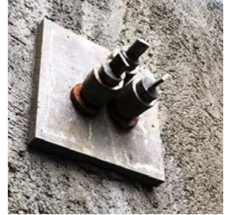
Tête de blocage pour clou tri-lame
