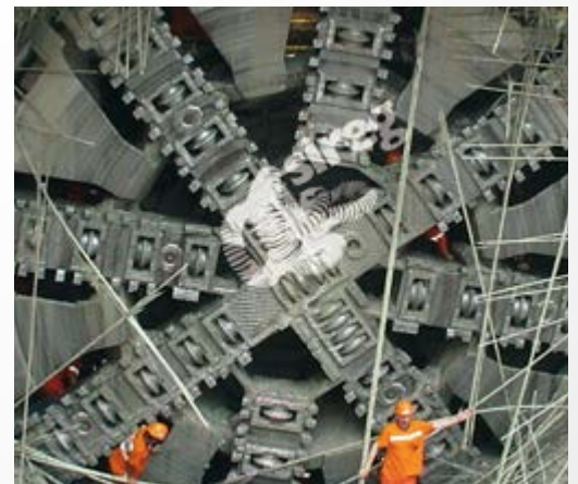
Passage du tunnelier à travers la paroi
