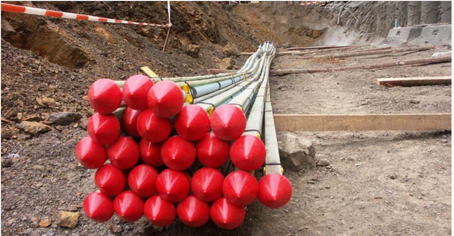
Clous DURGLASS® ED avec tube à manchettes d'injection
