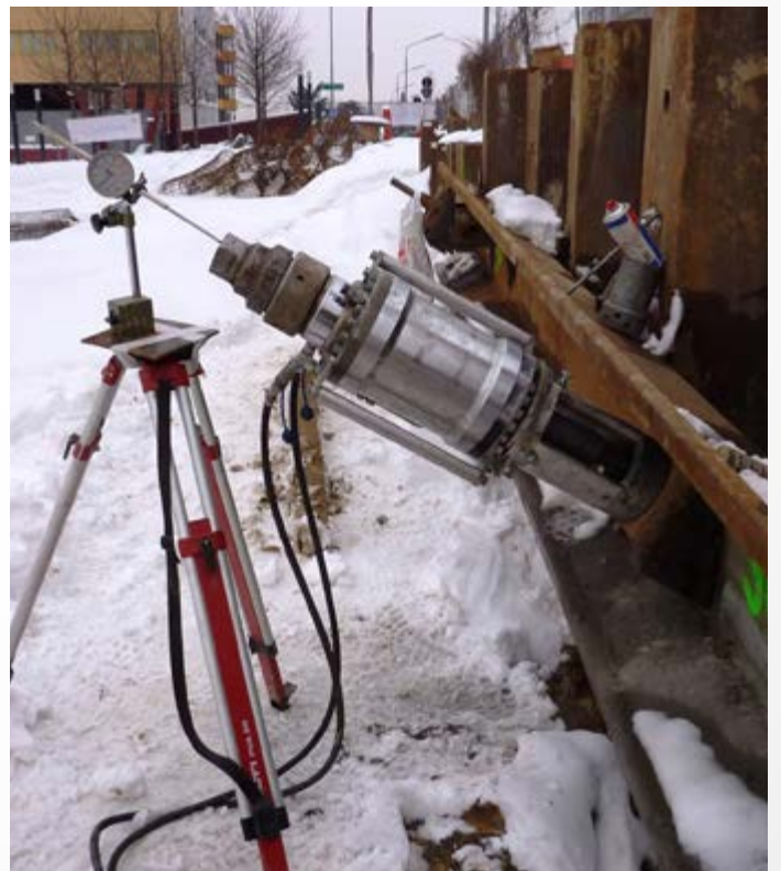
Mise en tension d'un tirant DURGLASS®
