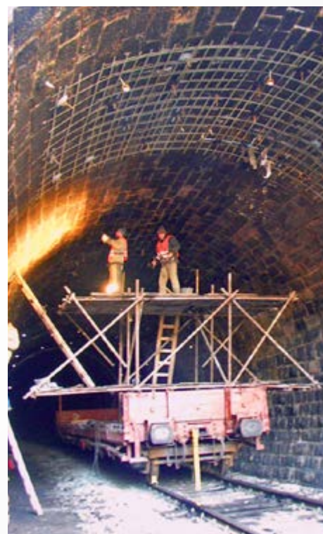
Treillis GLASSPREE® pour revêtement de tunnel
