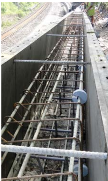
Cage d'armature GLASSPREE® le long d'un chemin de fer
